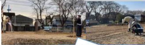
地面に設置した杭に施工高さを示す横板と釘を打ったトンボ丁張りを管理断面の左右端部に設置
