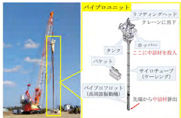
図-1 施工状況および施工機の構成
