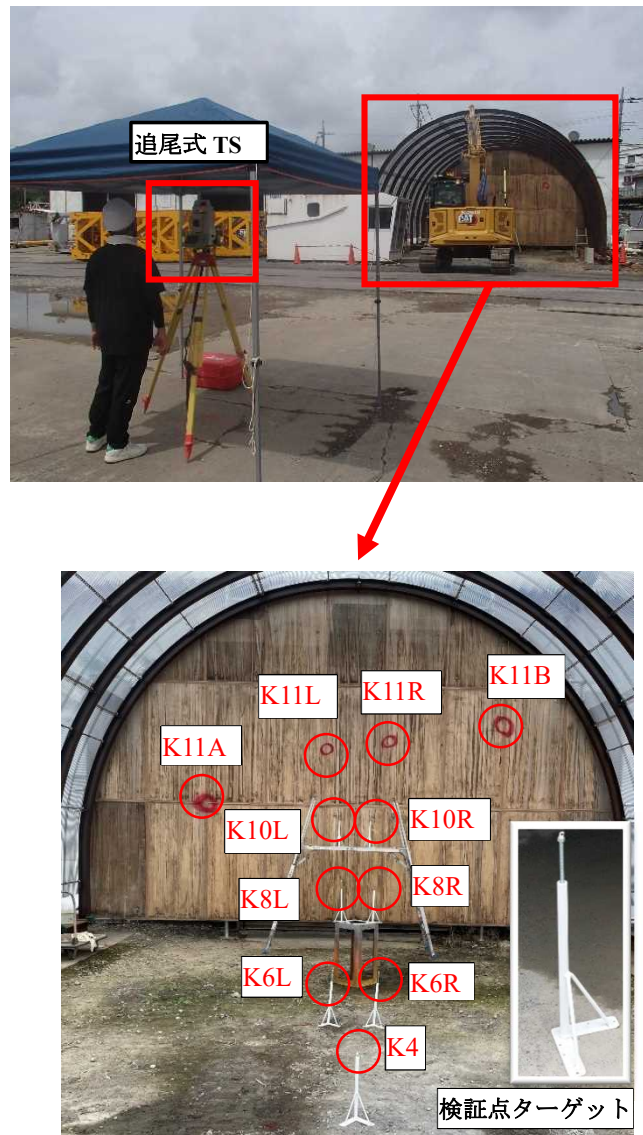
図-3 模擬トンネルにおける精度確認状況
