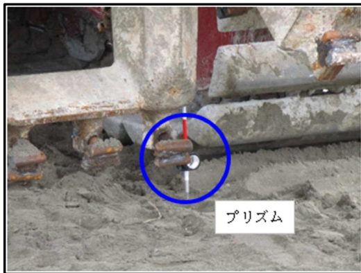
写真-2 攪拌装置先端
