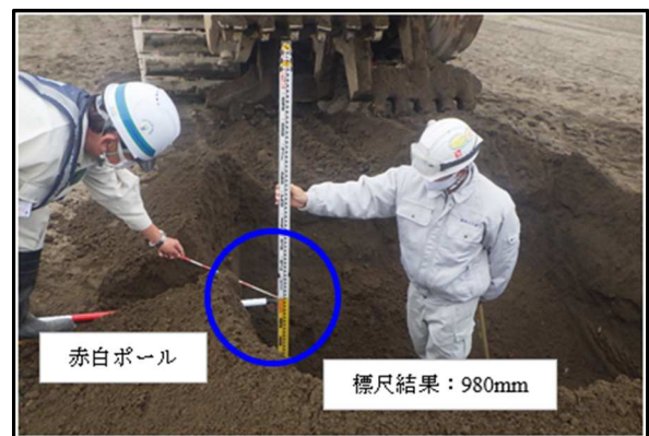
写真-4 標尺で切削深さを測量
