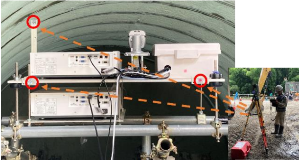
写真-3 プリズムシート測量
