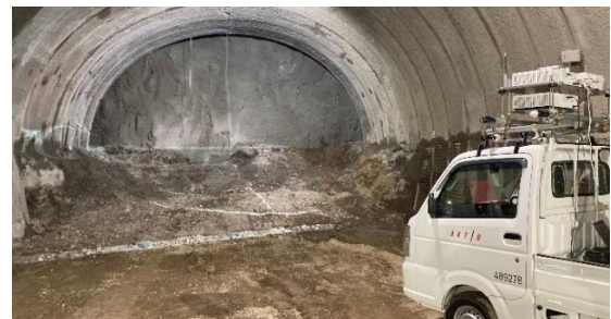
写真-2 3D計測機器設置
