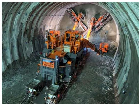
図-1 2ブームロックボルト打設専用機
