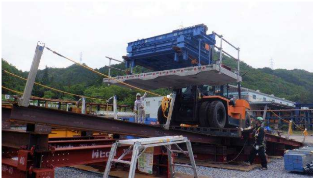
写真-5 実物大施工性確認試験実施状況
