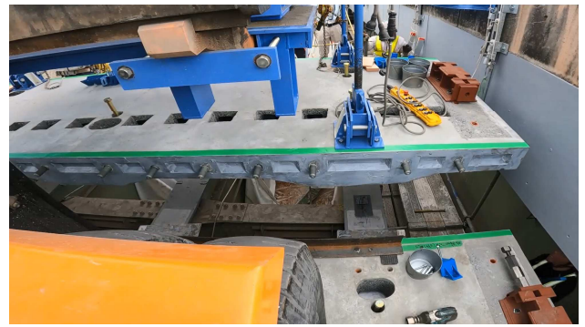
写真-7 PSジョイント床版架設開始
