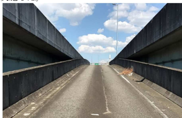
写真-1 試験橋梁の施工前状況
