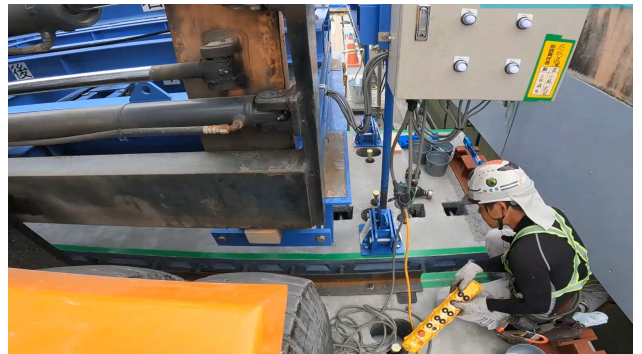
写真-8 心出し装置操作状況
