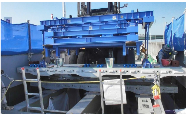
写真-6 PSジョイント床版運搬状況
