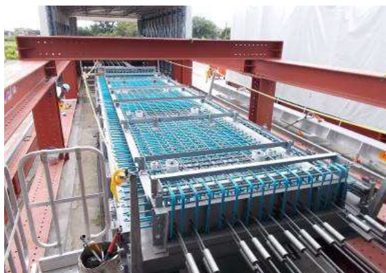
写真-14 床版製作状況
