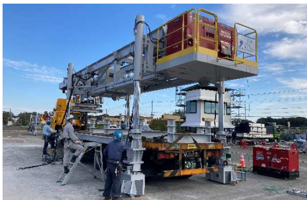
写真-2 架設機上部本体フレーム運搬・組立
