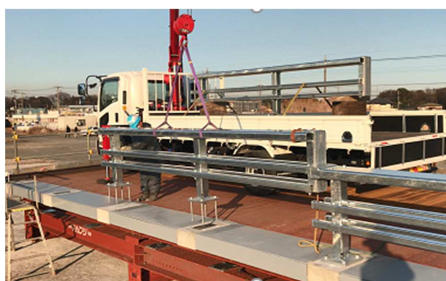
写真-12 施工安全性、サイクルタイム確認状況
