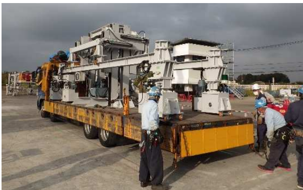
写真-1 架設機走行フレーム運搬
