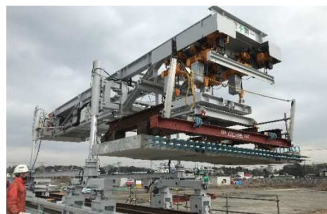
写真-6 床版架設機での床版架設状況
