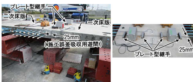
写真-11 交通振動プレート型継手施工性確認実験
