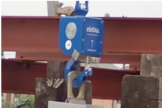
写真-8 自動開閉フック詳細
