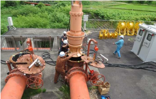
写真-3 吐出管とコラムパイプ(上) コラム形水中ポンプ 挿入設置状況(下)
