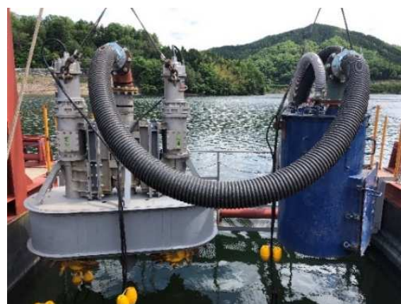
写真-4 オーガ付吸引機と中継ポンプユニット
