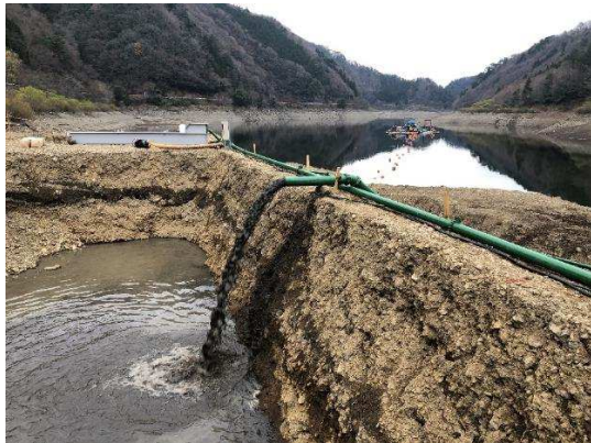
写真-7 湖岸沈砂池
