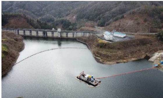
写真-1 ダム湖における試験施工
