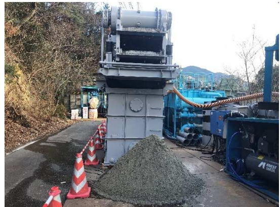
写真-8 陸上ヤード 砂回収状況
