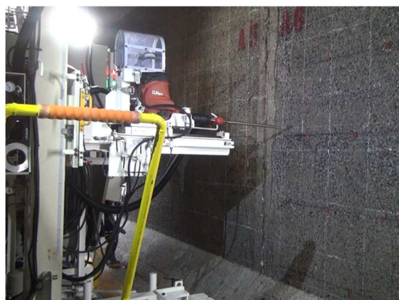
写真-5 自動削孔装置の自動削孔状況
