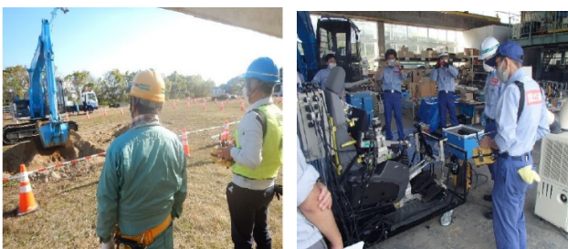
図-11 ロボQSの設営・稼働訓練の実施状況
