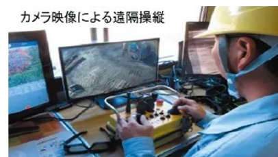
図-9 ロボ QS の遠隔操作状況
