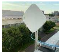
写真-2 アンテナ設置状況 (B 棟)
