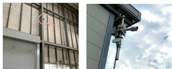
写真-1 カメラ設置状況(左:E棟, 右:F棟)
