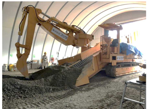
写真-5 模擬トンネル実験状況
