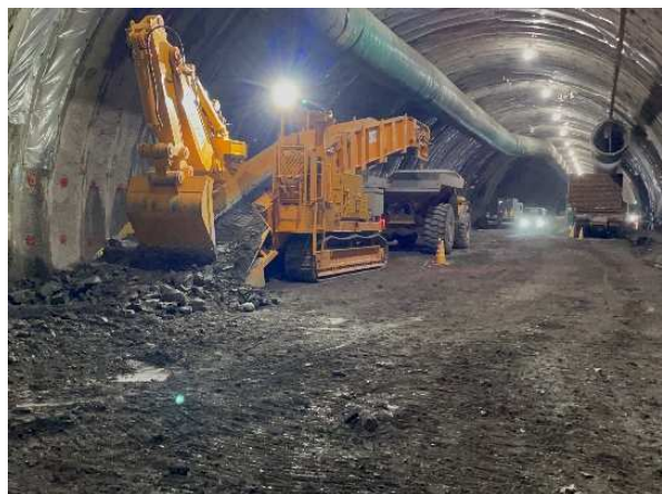
写真-9 トンネル坑内運用状況(前方)
