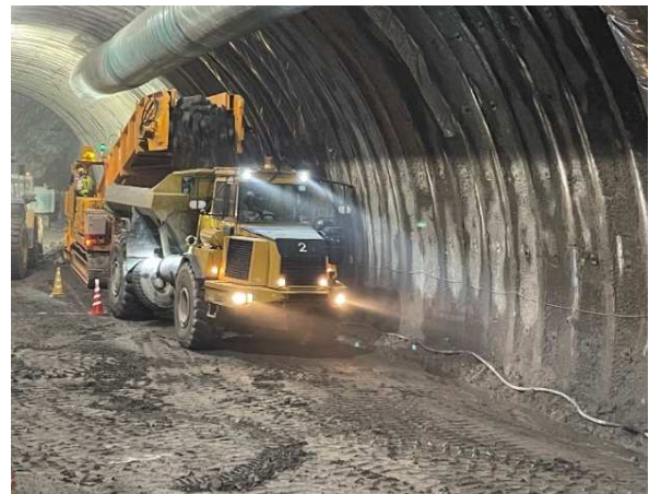
写真-8 トンネル坑内運用状況(後方)
