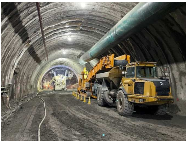
写真-10 切羽の早期解放状況
