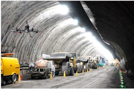
図-5 坑内の自律飛行状況
