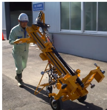
図-2 施工機の人力運搬状況
