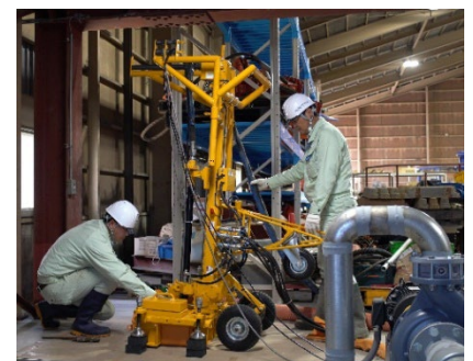
図-3 建屋内高さ制限下での施工
