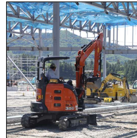
(屋内)建築工事
