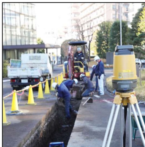
管路掘削工事
