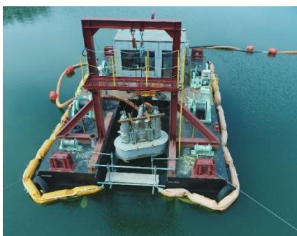
湖上台船設備
