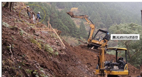
遠隔+丁張で掘削 危険区域に作業員
