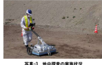
写真-3 地中探査の実施状況
