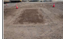
写真-2 埋設管配置完了状況
