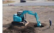
写真-5 従来建機による掘削作業
