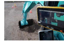
写真-4 ICT建機による掘削作業
