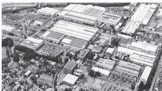
写真—1 工場全景
