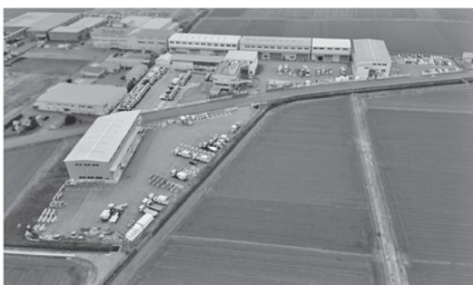
写真—4 工場全景
