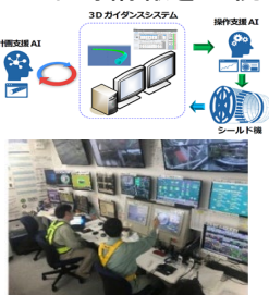
図-1 自動運転の現場実証
