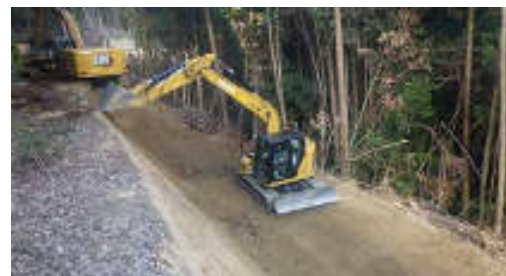
丁張間の目印がない箇所もモニターを見て正しい掘削が行え若手オペの育成も出来た。
