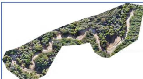
UAVによる着工前測量、出来形測量を実施、点群処理後、3D設計セータを作成。
