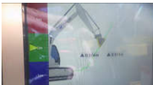
3D設計データを作成しバックホーに展開、モニターの設計面を見ながら掘削。
