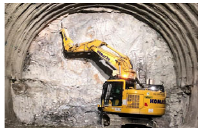
写真-2 遠隔操作油圧ブレーカ
