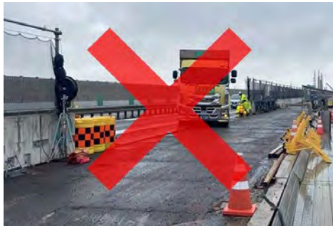
高速道路本線からの搬出入
