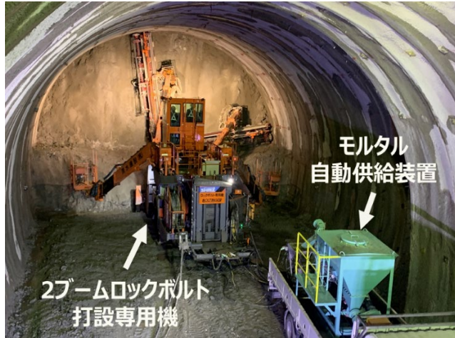
写真-1 2ブームロックボルト遠隔施工システム
