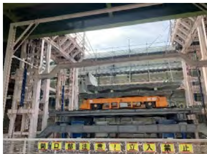
リフトアップ式揚重設備
