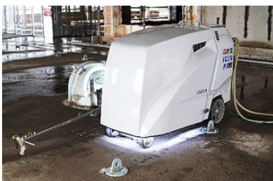
図-4 スラブ斜め切断カッター
