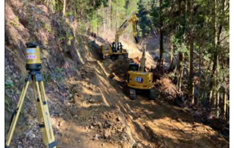
(ICT建機は2台導入し生産性向上を図る)
