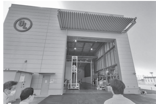
写真一2 大型電波暗室の外観（8m×8mの入口）
