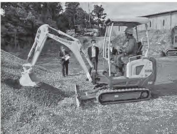
写真-6 竹内製作所製電動バックホウ
