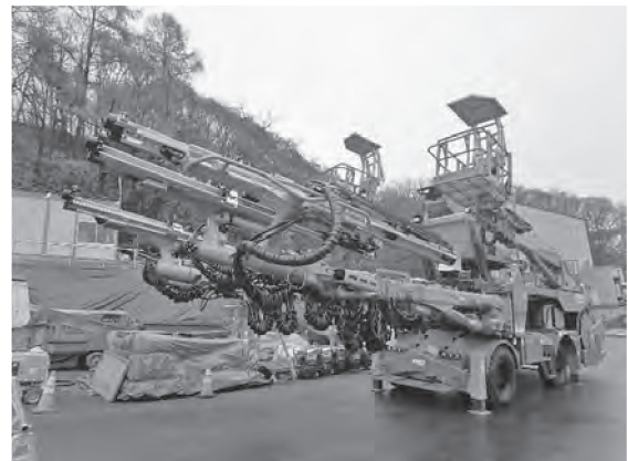
写真—1 フルオートドリルジャンボ（天神トンネル作業所現場概要資料より）
