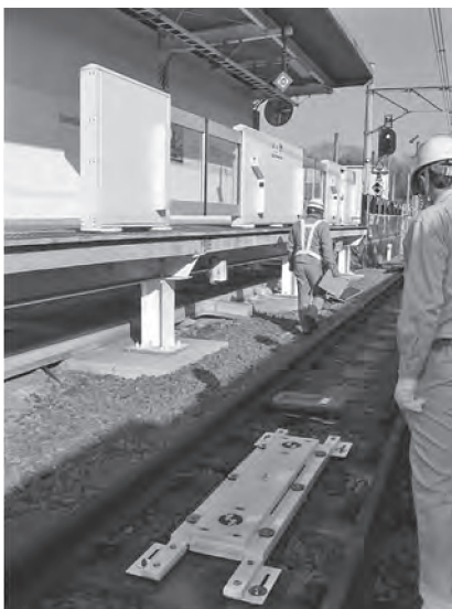
写真一八 車輪位置検知装置とホームドア
