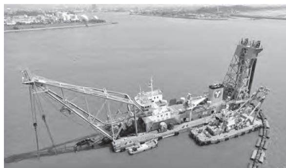
写真-1 筑波丸外観 (東洋建設(株)様 ホームページより)
