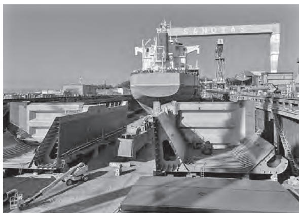
写真—7 ドック内新造船作業風景
