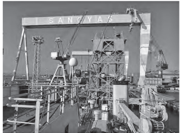
写真—4 筑波丸船橋から見た800tゴライアスクレーン
