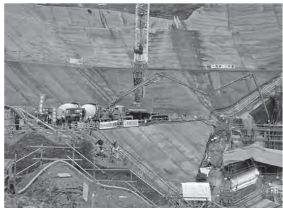
写真一 4 コンクリートポンプ打設
