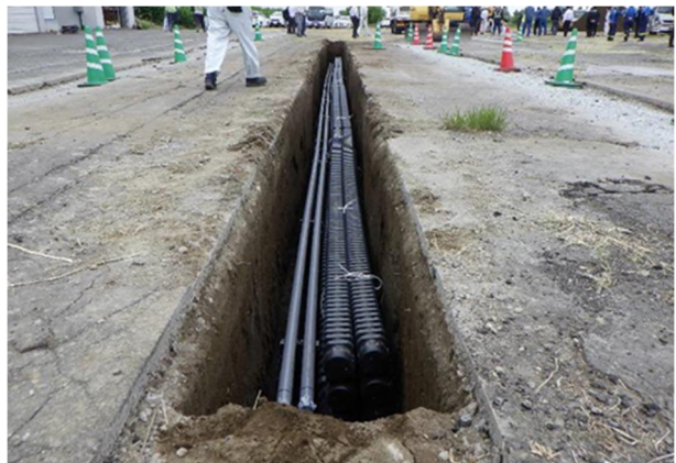
写真-5 敷設状況
