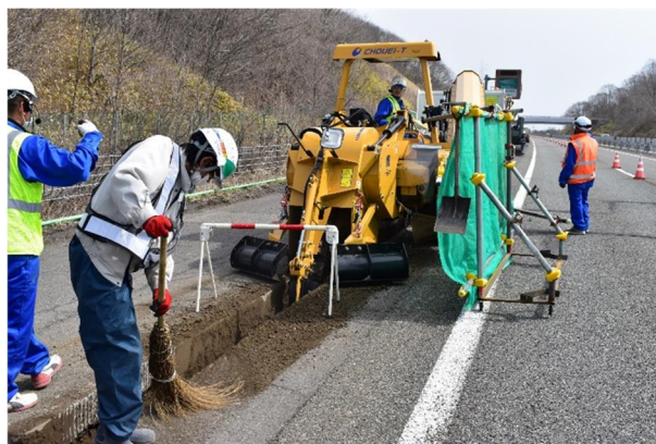
写真-1 掘削状況（高速道路での施工）
