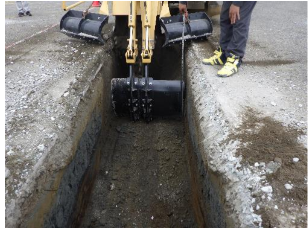
写真-8 掘削状況
