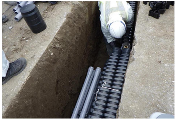
写真-4 敷設状況 (角型 FEP 管の接続)
