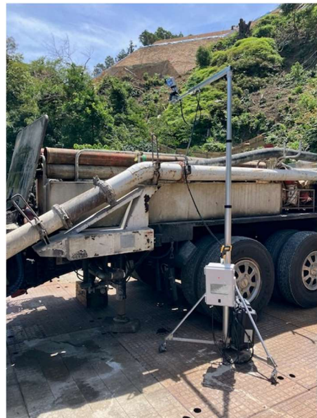
図-4 現場検証時設置状況
