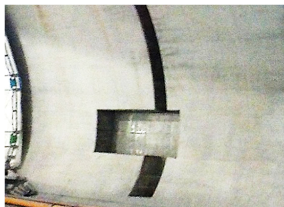
写真-8 箱抜き箇所の充填状態
