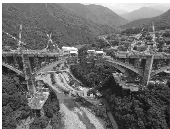
写真-1 河内川橋工事状況（下流側から望む）
