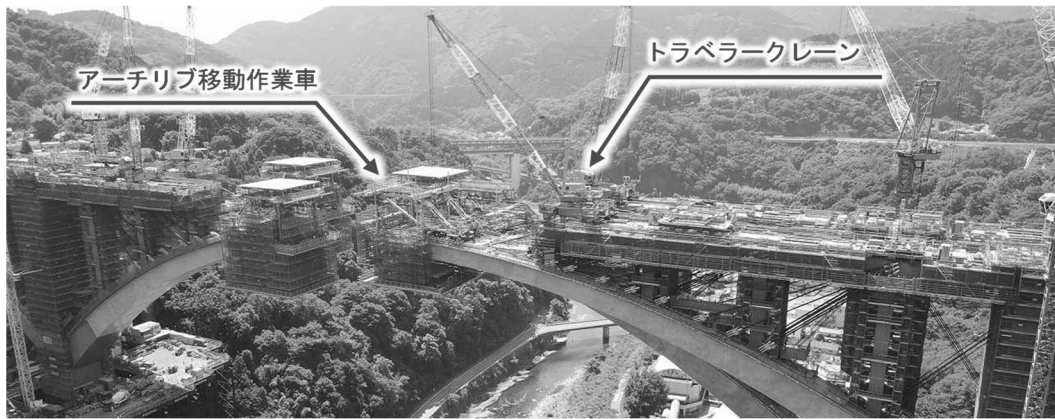
写真-5 移動作業車とトラベラークレーンの位置関係
