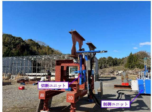
図-6 プラズマ切断装置の切断実験(梁切断)
