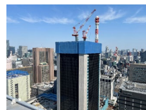
図-2 ブロック解体工法
