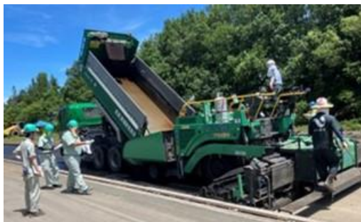
写真-6 アスファルト混合物の敷きならし
