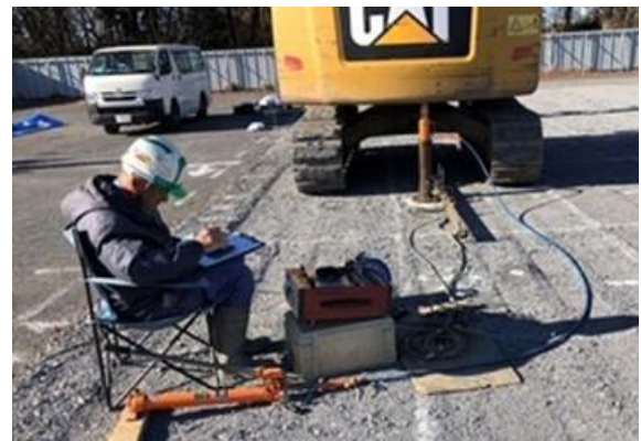
写真-5 平板載荷試験
