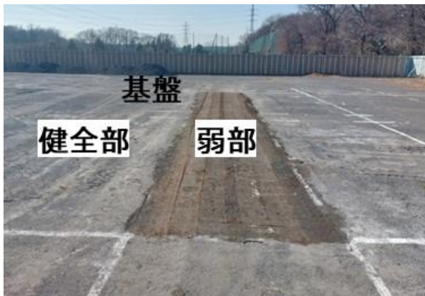
写真-1 基盤への弱部設置状況
