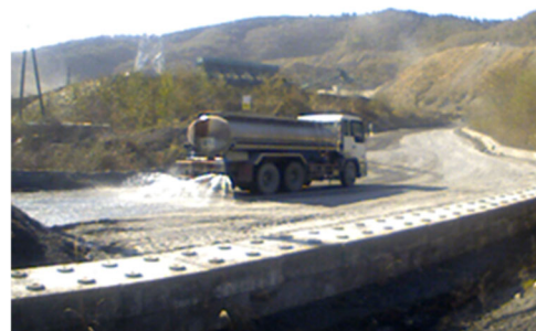
図-1 砕石場での散水による粉じん対策
