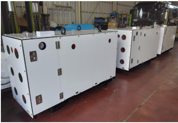
図 3-2 カードル 3 基が完成した状態
