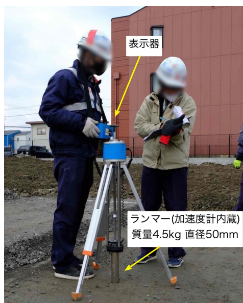
図-2 簡易支持力測定器による試験の様子
