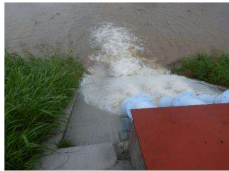
写真-3 排水運転状況 (R5.7 福智町実証設備)
