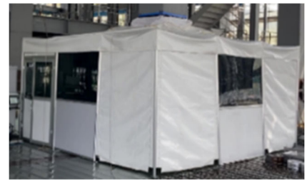
写真-11 システム養生
