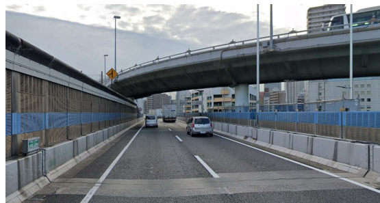
写真-1 工事対象橋梁京橋方状況
