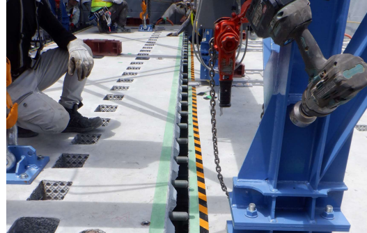
写真-2 PS 接合床版の接合作業状況
