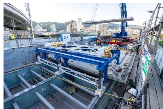
写真-7 床版架設機稼働状況
