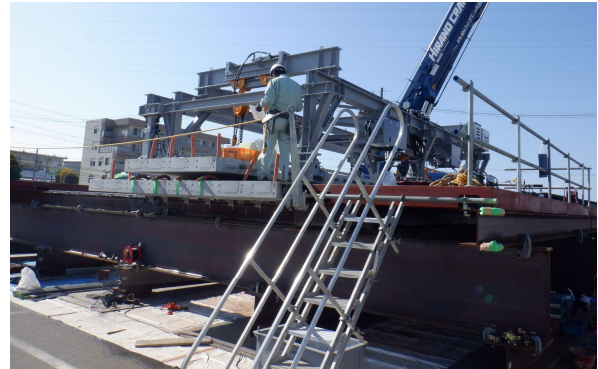
写真-3 実物大施工性確認試験
