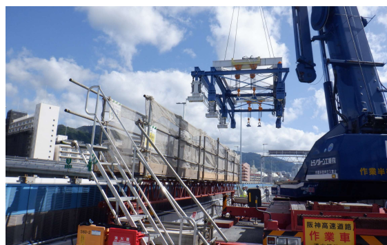
写真-6 床版架設機投入状況
