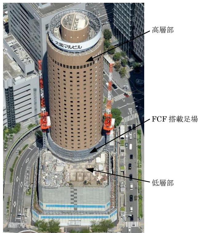
写真-6 施工建物
