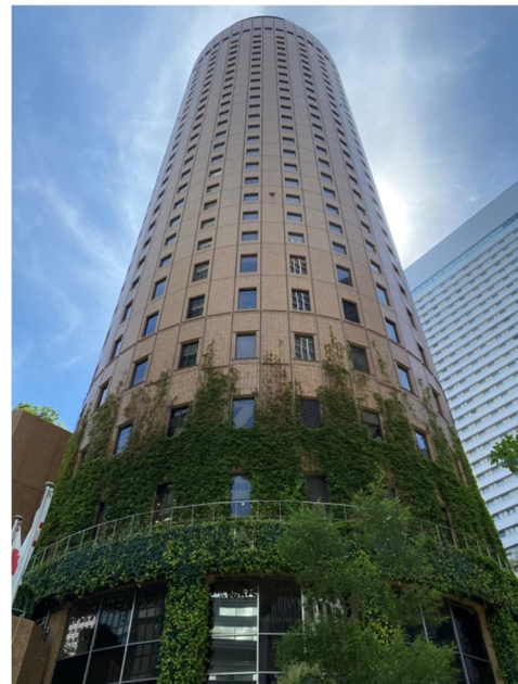
写真-4 施工建物
