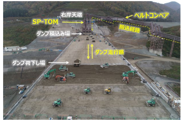
写真-3 堤体全景と材料搬送設備
