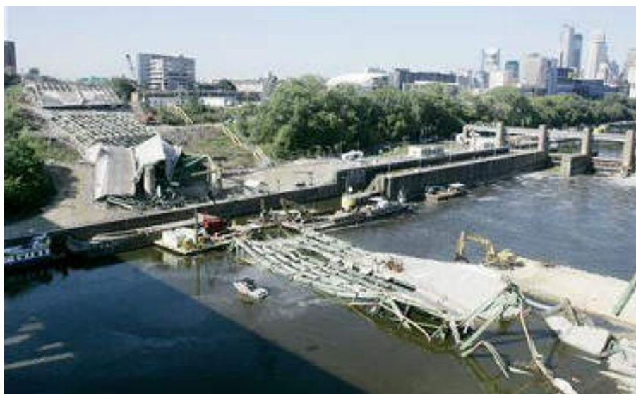
2007年8月 米国ミネアポリス 高速道路崩落事故
