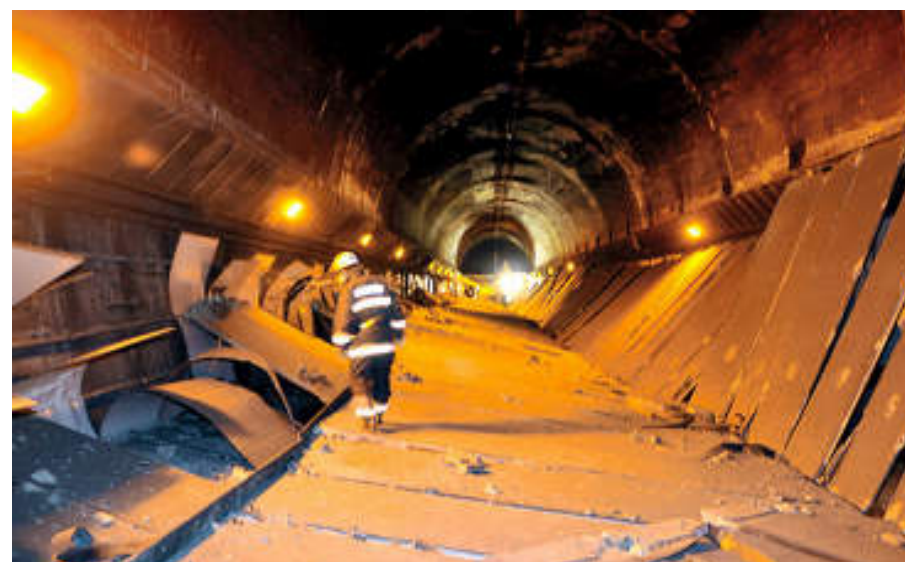
2012年12月 笹子トンネル 天井版崩落事故 15
