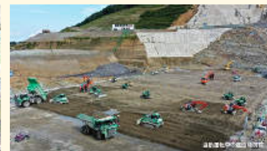
成瀬ダム（鹿島建設）
