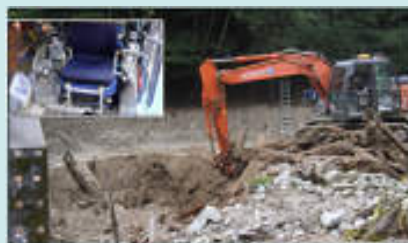
無人バックホウ稼働状況
