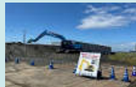
遠隔施工状況
