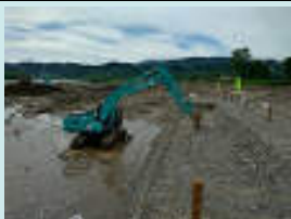
遠隔施工状況
