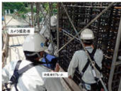
①臨場(受注者)の状況
