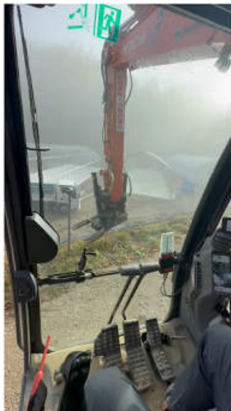
小基礎の引き抜き
