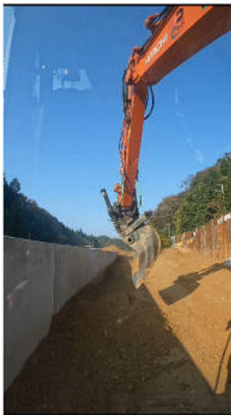
構造物際の施工
