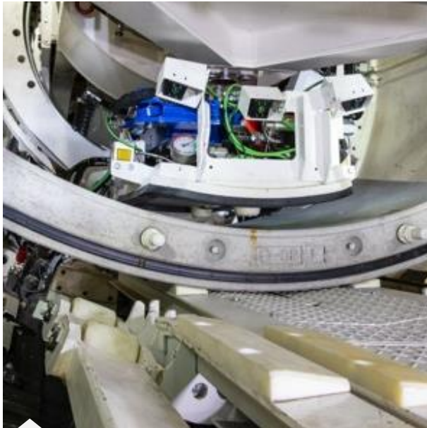
Automated ring building セグメント自動組立
