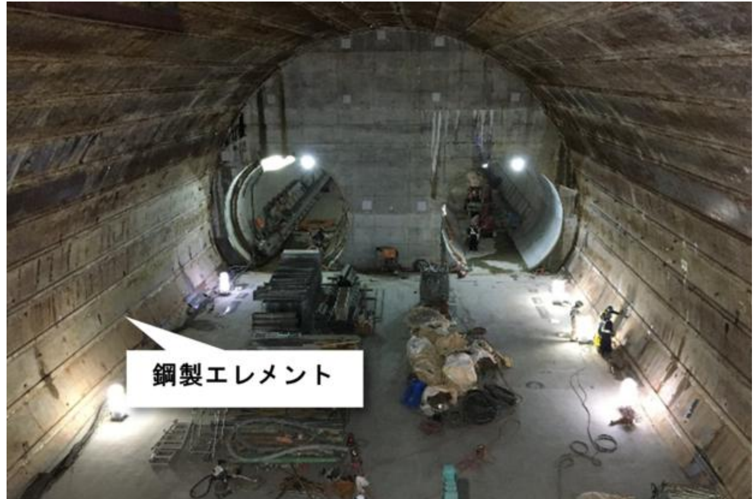
写真7-1 非開削トンネル内部構築状況
